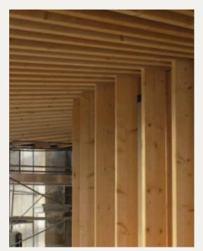
Il legno a parità di peso è 14 volte più resistente al carico rispetto all'acciaio e resiste a compressione quanto il cemento armato.
