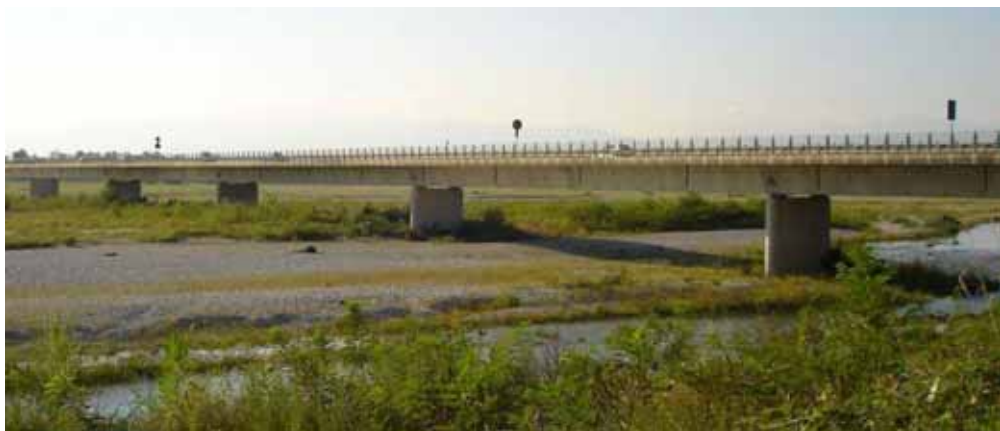
Figura 13: Il ponte della SS 13, fra Casarsa della Delizia e Codroipo.
