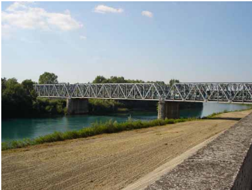
Figura 14: Il ponte ferroviario FFSS presso Latisana. Esso demarca la sezione critica. Allo stato presente (Settembre 2005) la trave principale del ponte si trova a quota 10,22 m sul medio mare.
