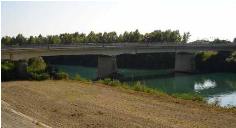
Figura 16: Il ponte della strada statale 14 nei pressi di Latisana.
