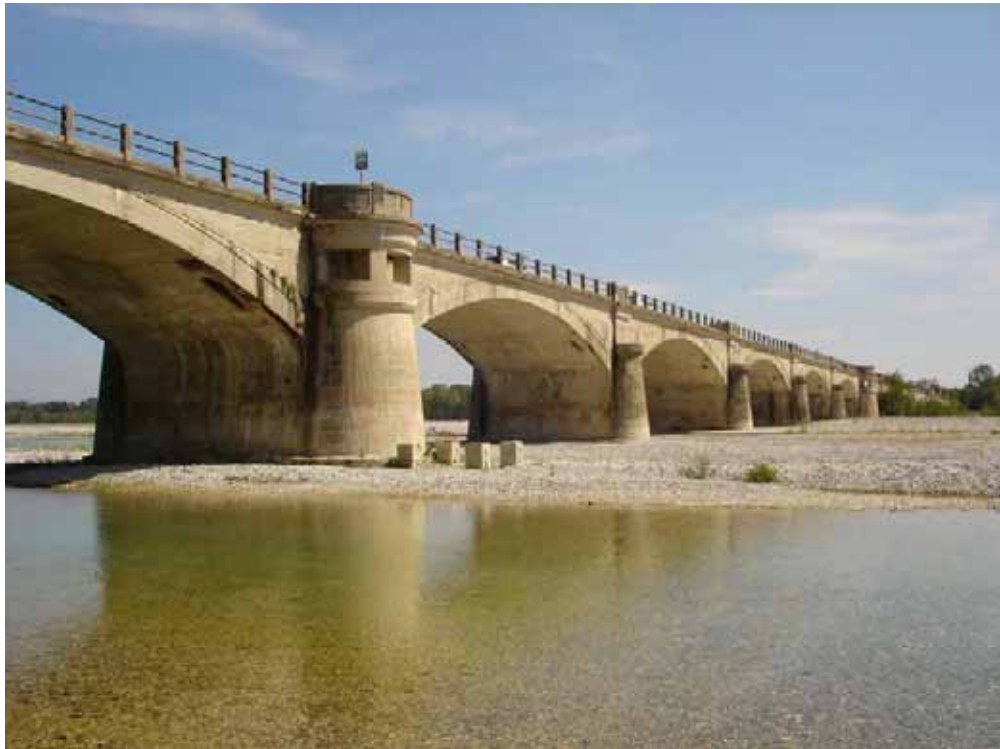
Figura 12: Il ponte di Dignano sulla strada provinciale 464 fra Spilimbergo e Dignano
